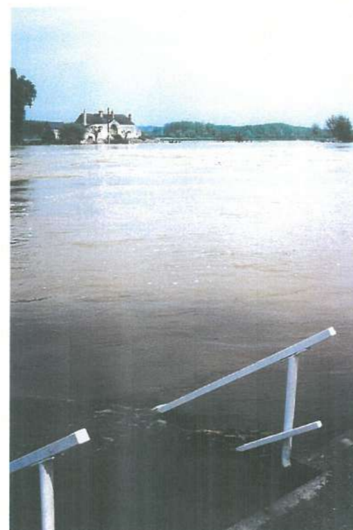
Bléré - maison éclusière.
